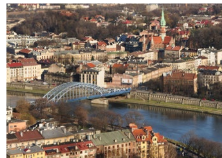
La partie de la Vistule séparant le quartier de Podgórze du centre-ville, © Anna Michalska | Fotolia
